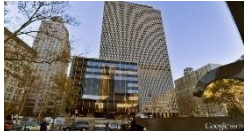
26 Federal Plaza Tenant Fit-out
